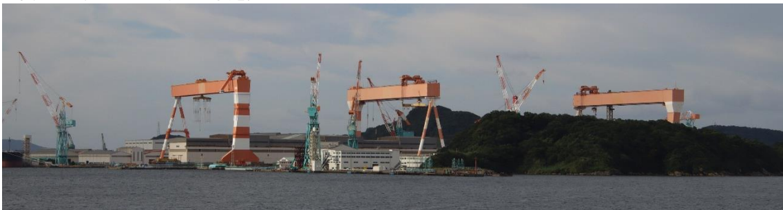
長崎港を出ると香焼のドックが見えてきました。三菱重工から大島造船に所有者が変わり、クレーンの上の三菱のマークが消されていました。
